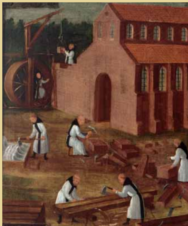
Maulbronner Mönche beim Kirchenbau auf der Stiftungstafel von 1450. In der Bildmitte arbeitet ein Mönch als Steinhauer mit dem Zweispitz. Rechts daneben ist ein Steinhauer mit Winkel und Zirkel dargestellt. Vor ihm liegen Zweispitz und Spitzer (Krönel). Ein anderer Mönch mischt den Mörtel. Hinten links steht ein Lastkran mit Tretrad und Steinzange (Repro: © Landesmedienzentrum BW)
